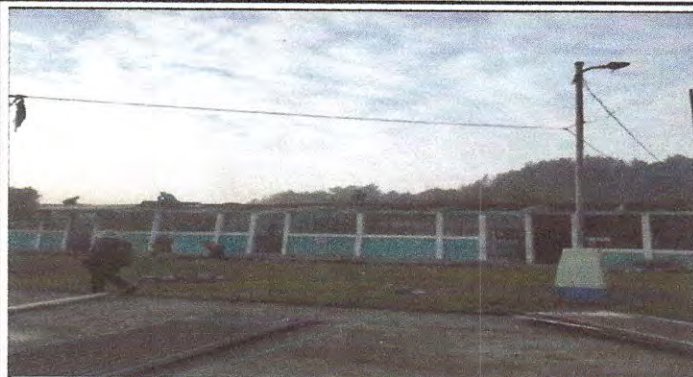
Foto 1: En la foto se observa el frente del centro educativo, la descinstalación de la lámina existente
