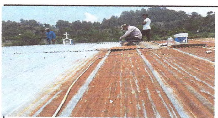
Foto 6: En esta foto se observa el herrero que esta pintando la lámina de un modulo del establecimiento, que no fue posible cambiarla.
