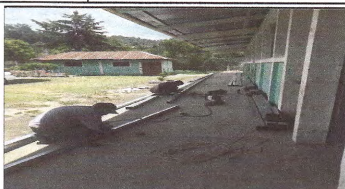
Foto 2: En la foto se observa el herrero que esta soldando los tubos de metal galvanizado para instalación del soporte la lámina troquelada calibre 26
