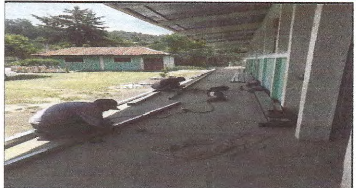
Foto 2: En la foto se observa el herrero que esta soldando los tubos de metal galvanizado para instalación del soporte la lámina troquelada calibre 26
