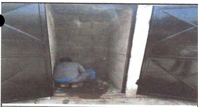
Foto 5: en esta foto se observa el albañil descinstalado la tasa existente, uno de los tres sanitarios
