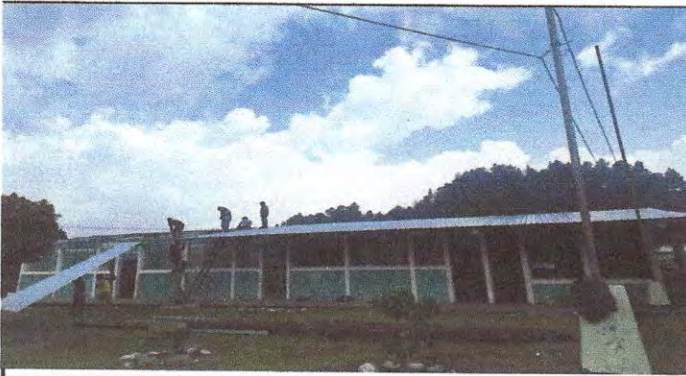
Foto 3: En la foto se observa la instalación de la lámina troquelada aluzinc calibre 26.
