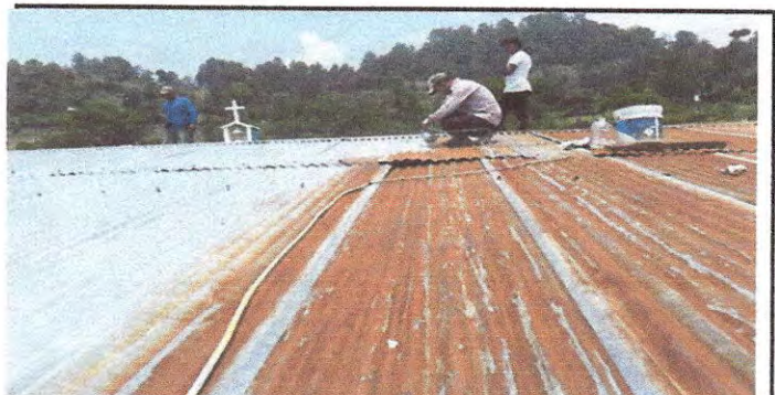
Foto 6: En esta foto se observa el herrero que esta pintando la lámina de un modulo del establecimiento, que no fue posible cambiarla.
